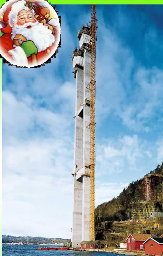
Grenland-híd, Norvégia, önkúszó zsáluzattal
