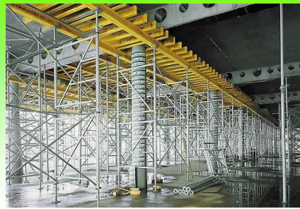
Alátámasztó állványzat, térbeli merevítésekkel (DOKA Aluxo) Alumínium, tehát könnyebb, az acél állványok nagyobb teherbírásúak
