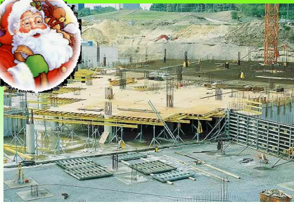
Fatartós födémzsaluzat (DOKAFLEX): 3 rendszerelem: födém támasz, zsaluzattartó, Dokadur tábla (műanyag keret) Bevásárlóközpont, Köln
