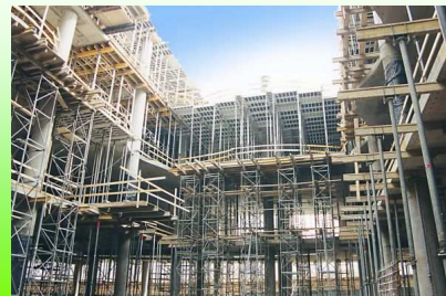
Alátámasztó állványzat, térbeli merevítésekkel (DOKA Aluxo) Alumínium, tehát könnyebb, az acél állványok nagyobb teherbírásúak
